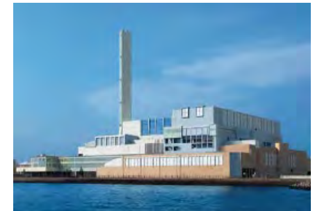
焼却工場の再整備や長寿命化工事
